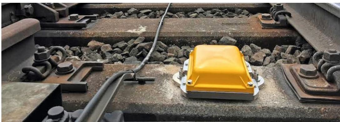
Lauscher zwischen Schienen: Sensible Elektronik schlägt Alarm, bevor die Betriebsstörungen kommen. Bild: Konux
