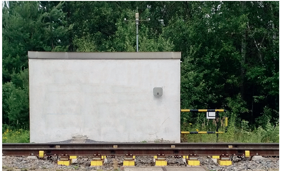
Abb. 2: RFID-Antenne am Gleis
